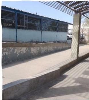
CONSERVACIÓN PAVIMENTOS, RAMPAS Y TALLER COCINA LICEO A-22. (EN EJECUCION)
