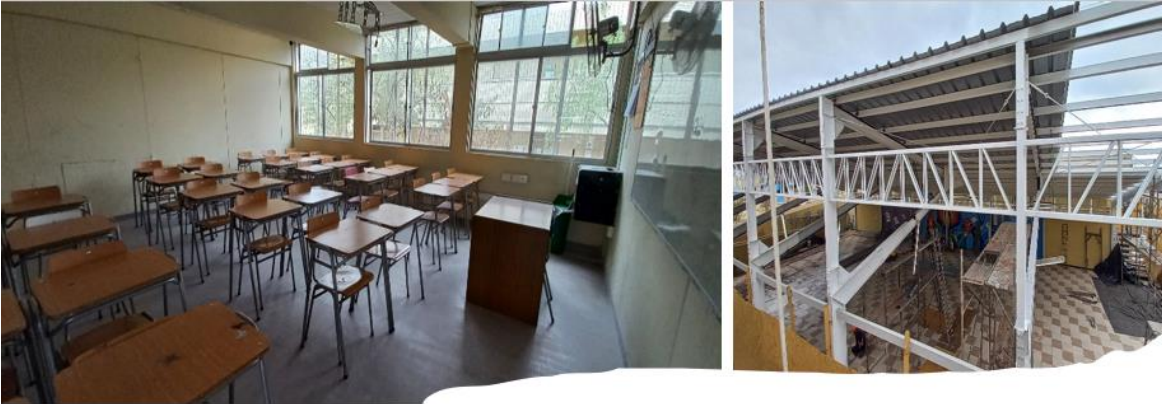
CONSERVACIÓN EMERGENCIA LICEO INDUSTRIAL EULOGIO GORDO MONEO A-16. (EN EJECUCION)
