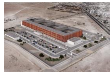
Hospital de Alto Hospicio (en construcción)
