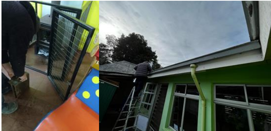
SALA CUNA CARAMPANGUE, limpieza de estufas y reparación de goteras.
