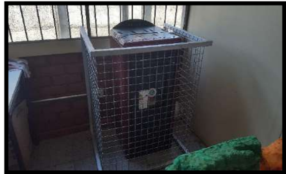
"Instalación de calefactores a pellets en diversos recintos Escuela Quilamapu"
