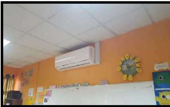
"Instalación de sistema de calefacción Escuela Palestina"
