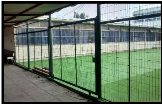
"Instalación Pasto sintético y cierres metálicos Liceo Lib. Bdo. O'Higgins"
