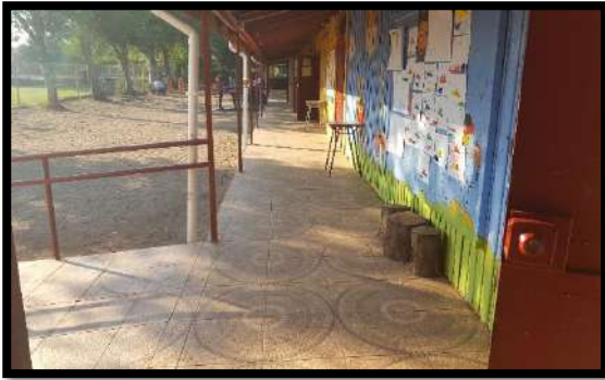
"Mejoramiento de Pasillos y diversas dependencias Escuela Antonio Machado"
