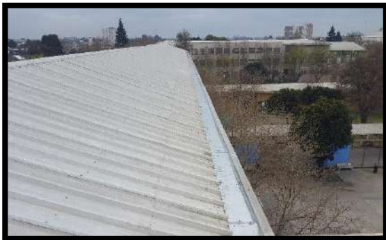
"Cambio Canaletas tercer piso Liceo Narciso Tondreau"
