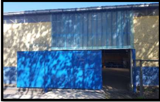
"Mejoramiento de Baños y Portón de acceso Gimnasio Escuela La Castilla"
