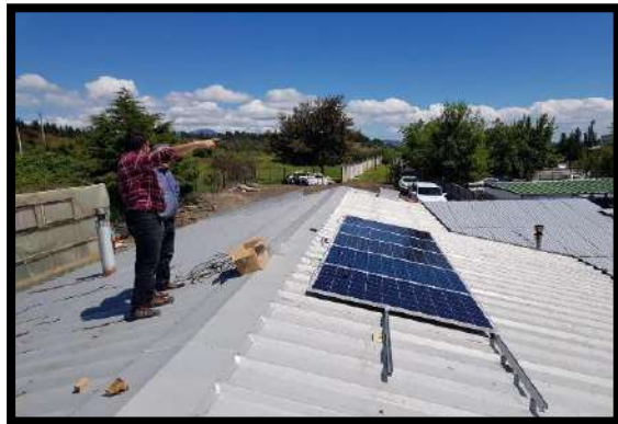
Instalación de paneles solares en Escuela Quinchamalí
