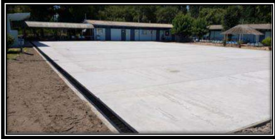
Escuela Colliguay, Habilitación de Radier para Patio Abierto.
