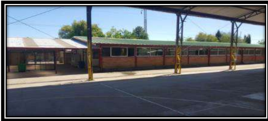
Liceo Libertador Bernardo O'Higgins, Conservación de Cubiertas
