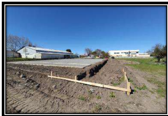
Escuela La Castilla, Habilitación de Cancha de Hockey (en ejecución)
