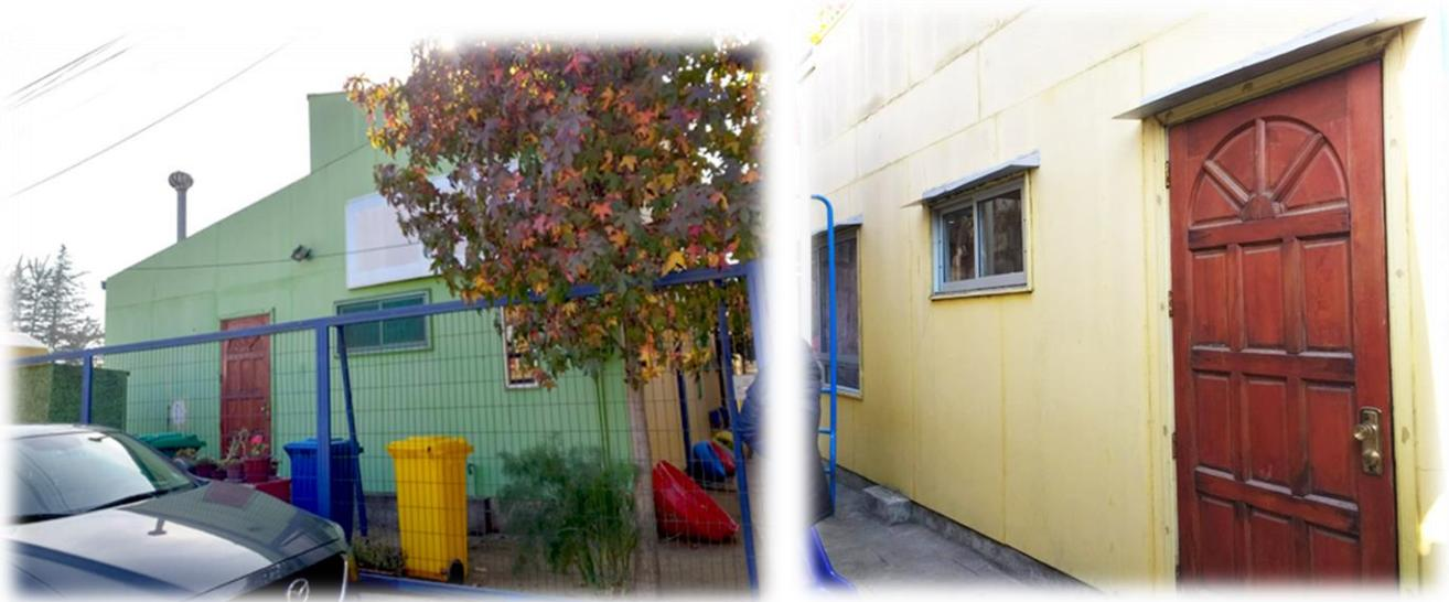
La intervención a realizar considera el cambio total del revestimiento exterior del edificio, actualmente en planchas de fibrocemento deterioradas por la acción del clima en la zona. El proyecto pretende solucionar el problema de infiltraciones de humedad y mejorar la imagen del establecimiento a través de la instalación de siding de PVC.
