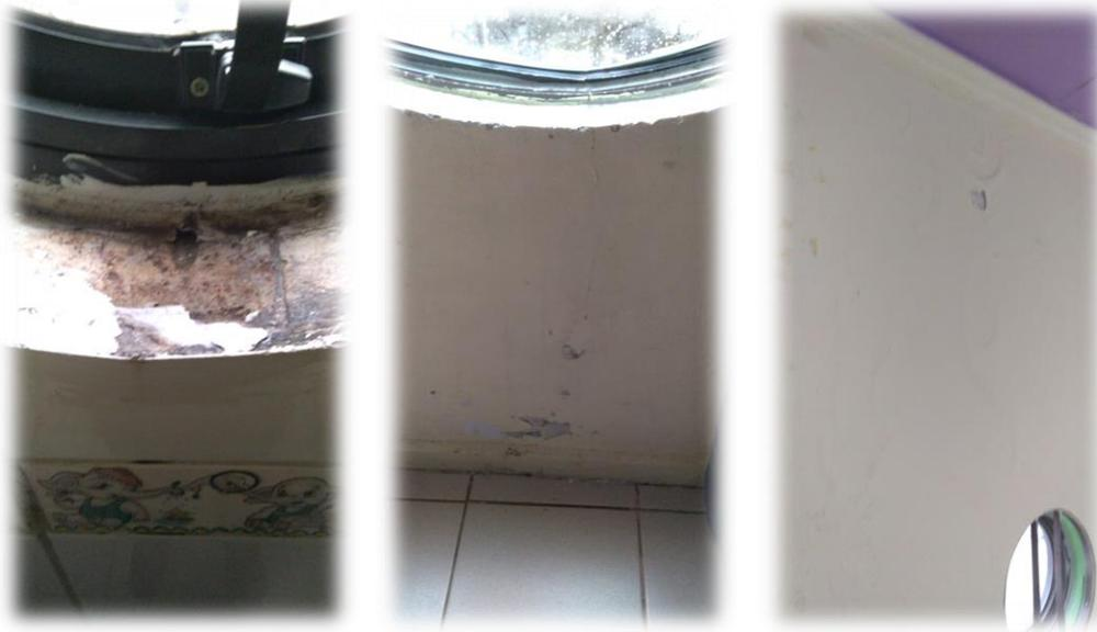
El proyecto consiste en realizar una mantención general de revestimiento del edificio, el cual presenta daños debido al clima costero al que se expone. Además de reparaciones de pintura en el interior y fachadas exteriores.
