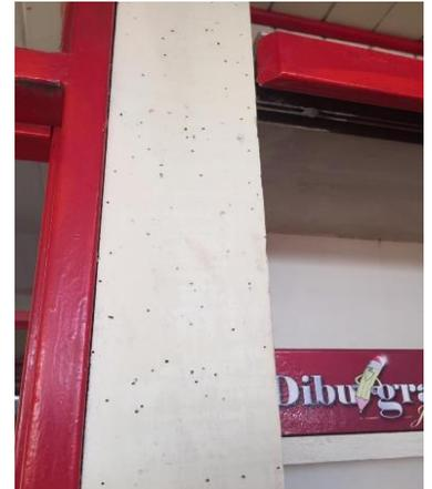
El edificio presenta un deterioro en su revestimiento interior, principalmente muros y tabiques. El proyecto considera pintura en estas áreas, las que están afectadas por la humedad y desgastadas por el uso y el paso del tiempo.
