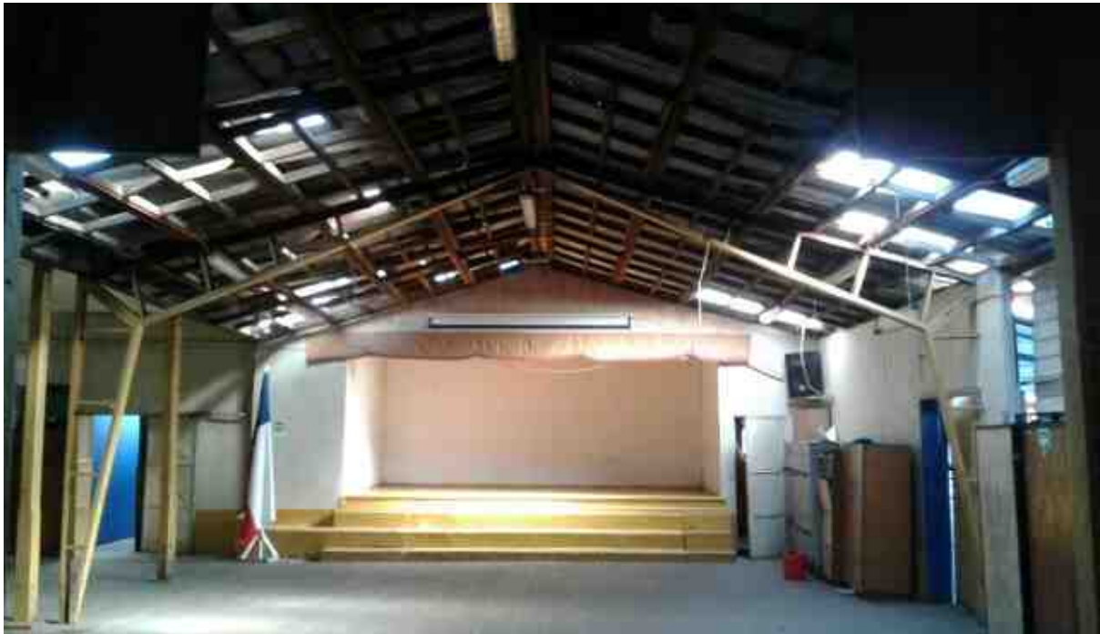
Mejoramiento Patio Escuela Adelaida.
