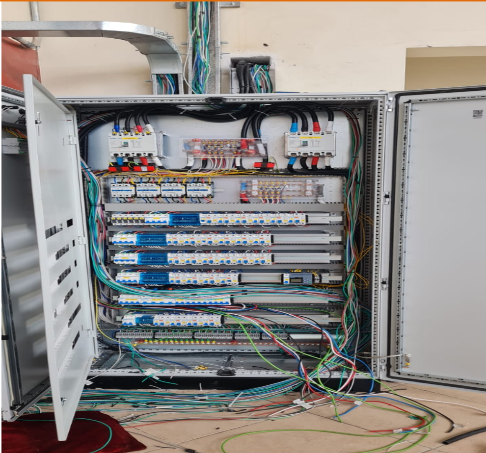
Figura 21. Imagen Tablero General Liceo Bicentenario
