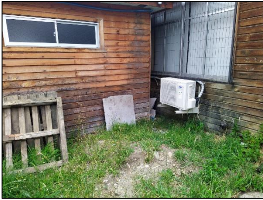
Imagen 01, patio de servicio cocina, nivelación e instalación
