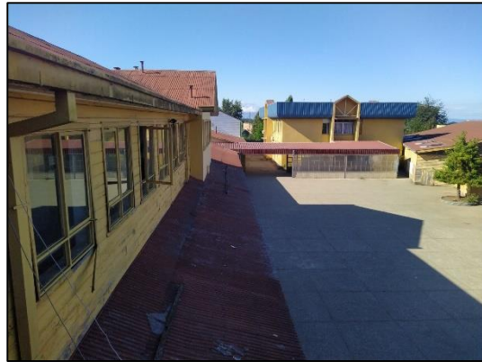
Imagen 32, canaletas de aguas lluvias patio interior del
