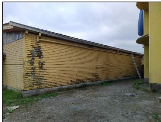
Imagen 10, canaletas sector gimnasio se retiran.
