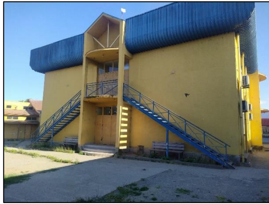
Imagen 36, mejoramiento techumbre pabellón del lago
