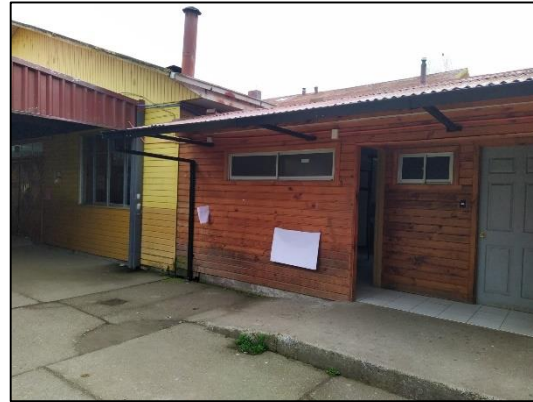
Imagen 16, canaletas y bajadas de aguas lluvias SS.HH. enseñanza media.
