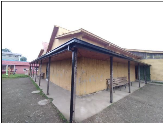
Imagen 13, canaletas y bajadas de aguas SS.HH. nivel básico
