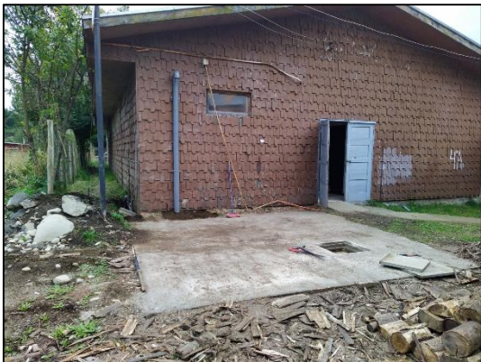
Imagen 17, losa de hormigón del pozo absorbente
