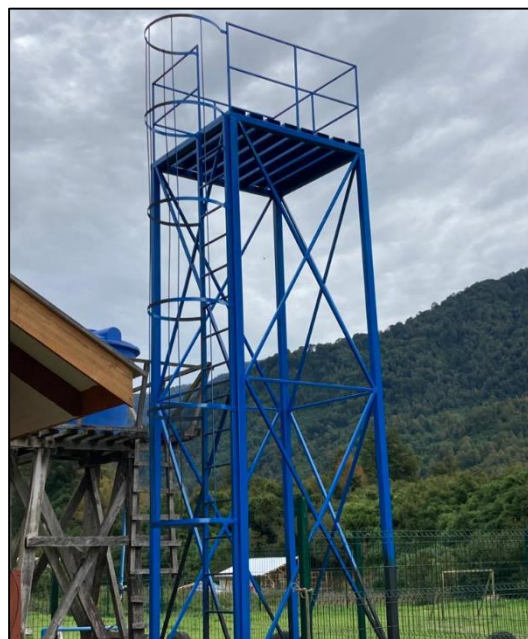
Imagen 30, nueva estructura torre
