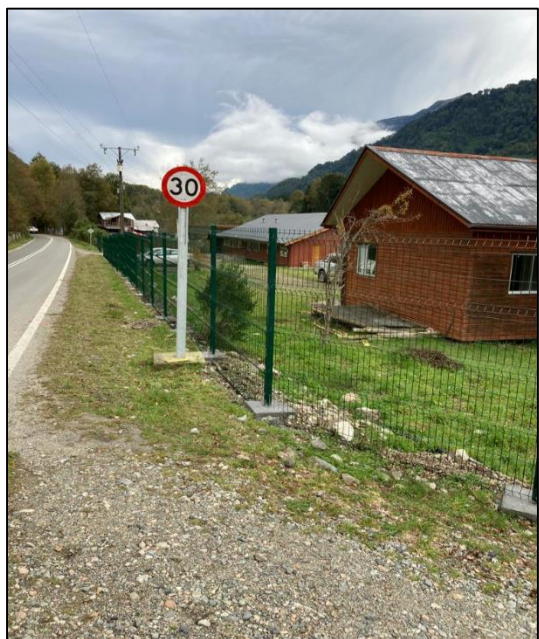
Imagen 29, actual cierre perimetral frontal establecimiento
