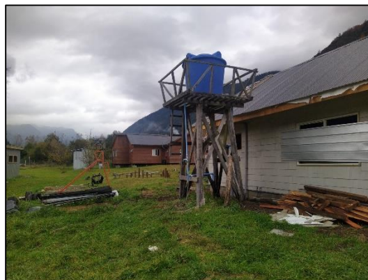
Imagen 28, torre antes de ser intervenida
