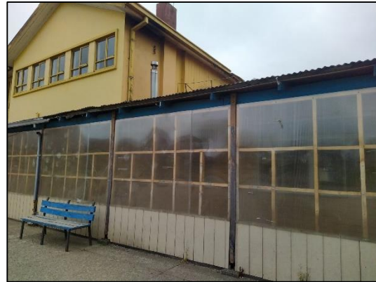
Imagen 04, retiro de canaletas y bajadas de aguas lluvias, patio interior
