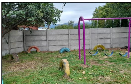
Imagen 22, patio exterior con mejoramiento cierre
