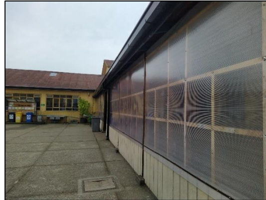
Imagen 12, pasillo costado comedor del establecimiento
