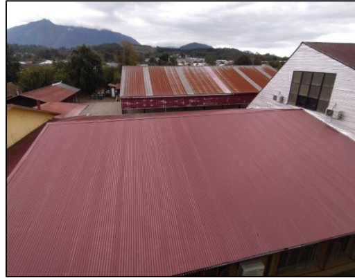
Imagen 26, techumbre pabellón cordillera, después del
