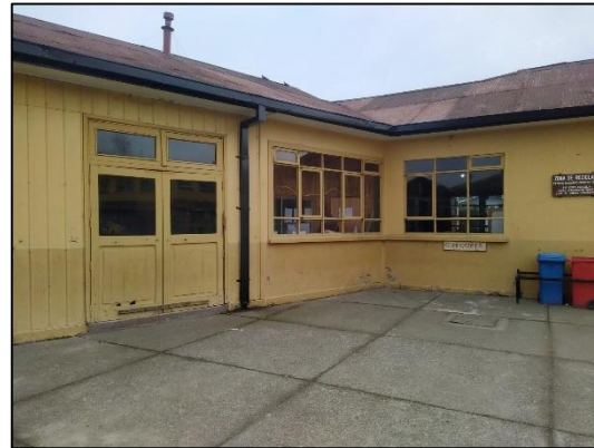
Imagen 14, canaletas y bajadas de aguas lluvias pabellón principal
