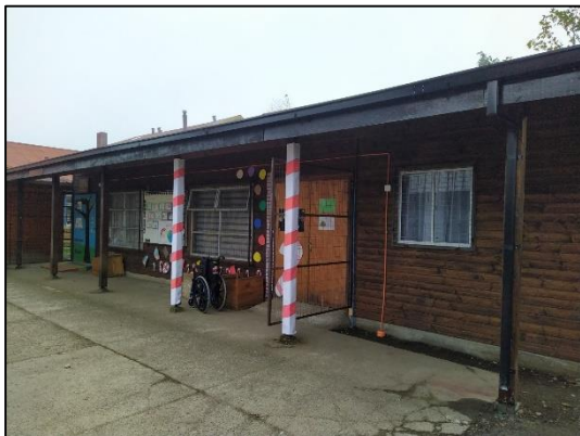
Imagen 15, canaletas y bajadas de aguas lluvias salas nivel especial
