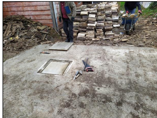
Imagen 18, losa de hormigón del pozo absorbente
