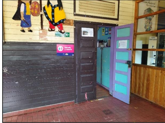
Imagen 34, retranqueo de puertas en pabellón principal
