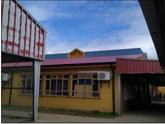
Imagen 25, techumbre pabellón cordillera, después del
