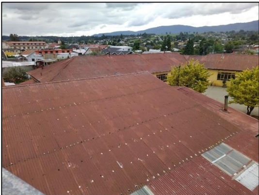
Imagen 37, recambio de techumbre gimnasio
