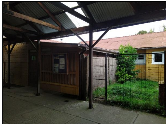
Imagen 38, recambio de techumbre sala de ciencias
