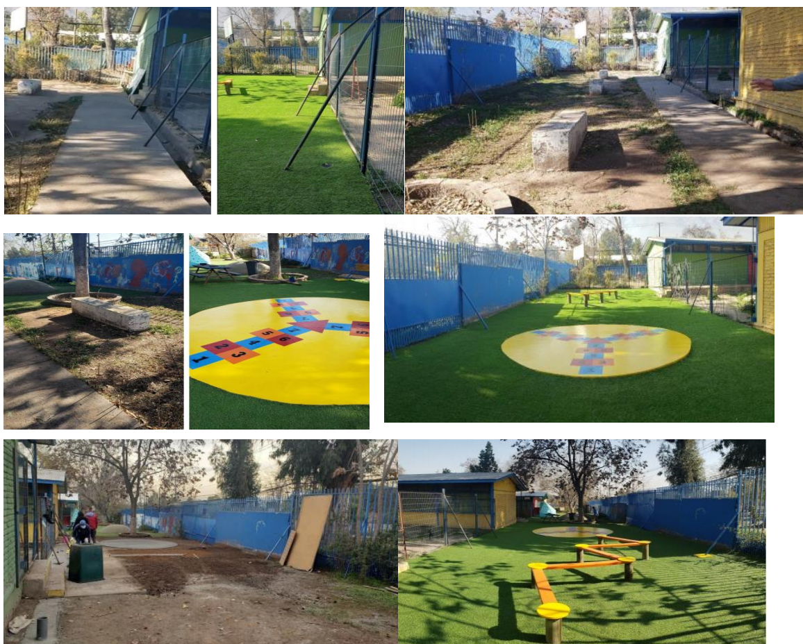
Mejoramiento Patio Básica Colegio Bicentenario Complejo Educacional La Reina:
