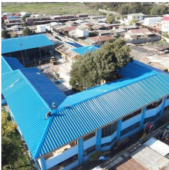
Infografía de intervenciones ejecutadas Escuela Herés de Iquique.
