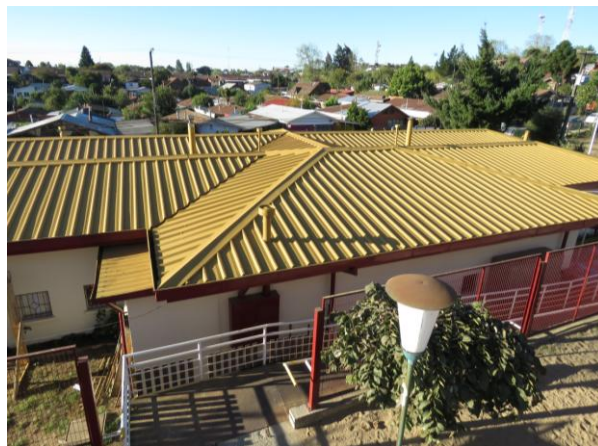
Techumbre del sector parvulario de la "Escuela Canadá".
