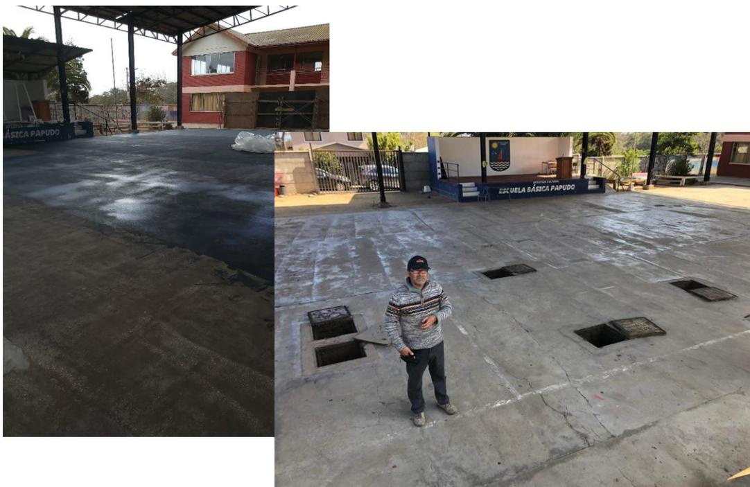
Se realizó la imprimación y se dio partida a la colocación del material asfáltico.
