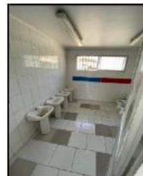
Las salas de clases de párvulo contaban con un pavimento compuesto de cerámica bastante deterioradas muchas de ellas fisuradas y desprendidas. El proyecto retira todo el pavimento existente incluyendo lo baños y se instala un nuevo piso unificando las 2 salas más las 2 baterías de baño existente, además se cambia el color a uno más claro, dando mayor iluminación natural a los recintos.
