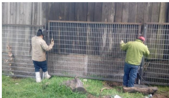
Construcción del cierre perimetral del establecimiento lado oeste y norte
