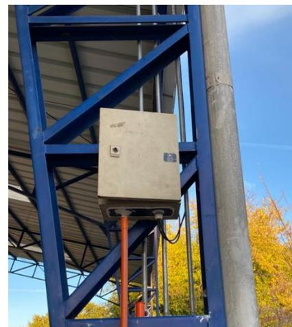
Escuela General Cruz, la antena se encuentra conectada y energizada directamente al rack de telecomunicaciones, se alimenta a través de un inyector Poe ubicado en el rack instalado por Telefónica del Sur en el establecimiento.
