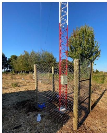
Escuela Valle Hermoso, En este establecimiento, la antena está alimentada por un inyector Poe ubicado en un armario metálico instalado en el gimnasio del colegio, a este armario se llega con un arranque eléctrico desde un primer armario que se encuentra en el mismo gimnasio del establecimiento donde se instaló un automático de protección.
