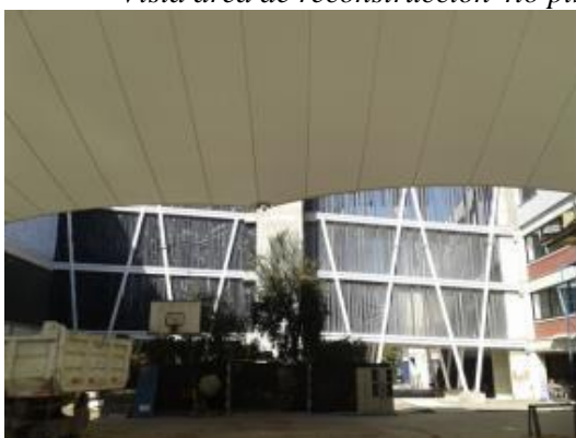
Tensoestructura y pasarela desde cancha
