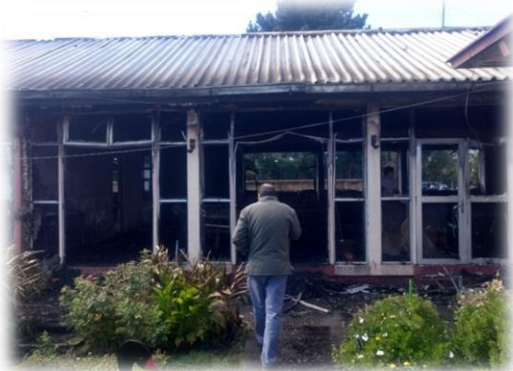
Demolición parcializada estructura internado Liceo Bicentenario Hotelaría y Turismo.
