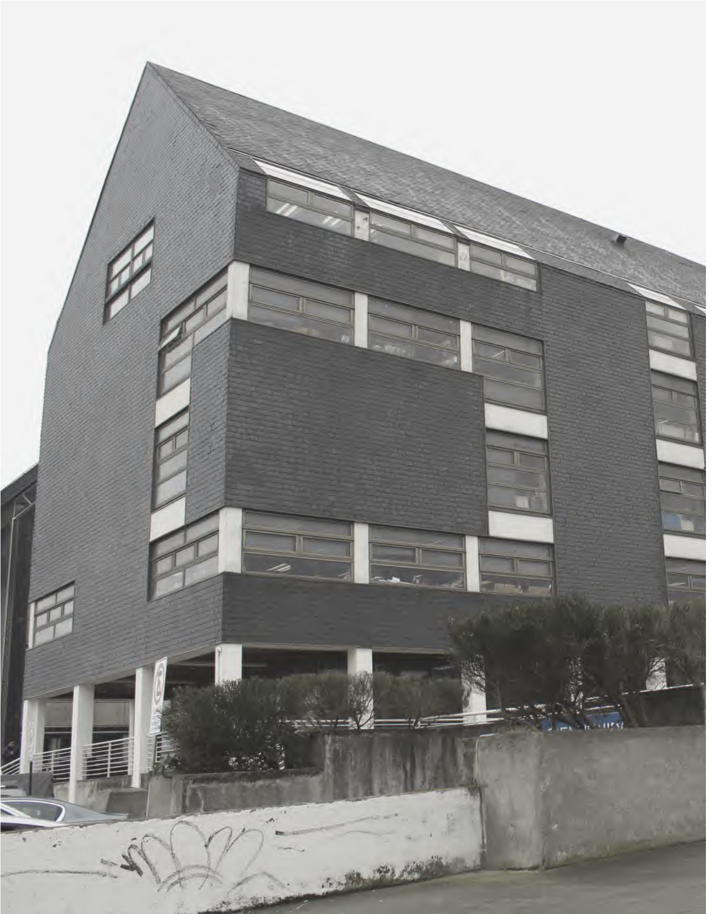
"EDIFICIO CONSISTORIAL II" MUNICIPALIDAD DE PUERTO MONTT
