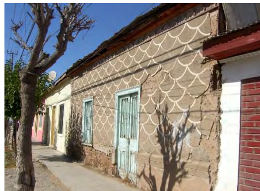
Parte de una de las primeras escuelas de Punitaqui
