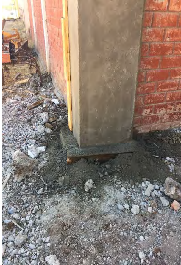
Mejoramiento pilares salas de clases
