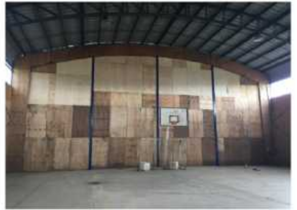
Refuerzo estructural y mejoramiento de revestimiento interior y exterior, en fachada norte de gimnasio.
