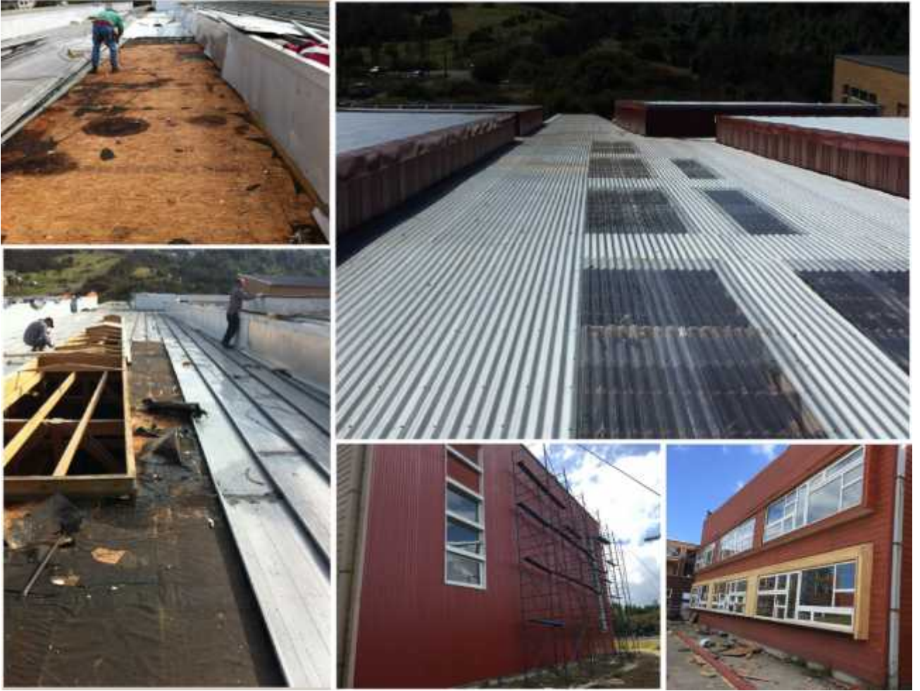
Reposición de cubierta y cielo en edificio principal, reposición de revestimientos de muros y cajones de ventanas.
