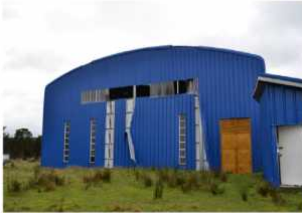
Refuerzo estructural y mejoramiento de revestimiento interior y exterior, en fachada norte de gimnasio.
