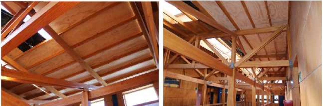
Reposición de cubierta y cielo en edificio principal, reposición de revestimientos de muros y cajones de ventanas.
