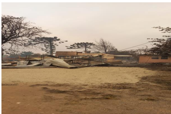
Escuela después del incendio
