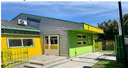
Jardín Cuncuna Amarilla remodelado (vista exterior)
