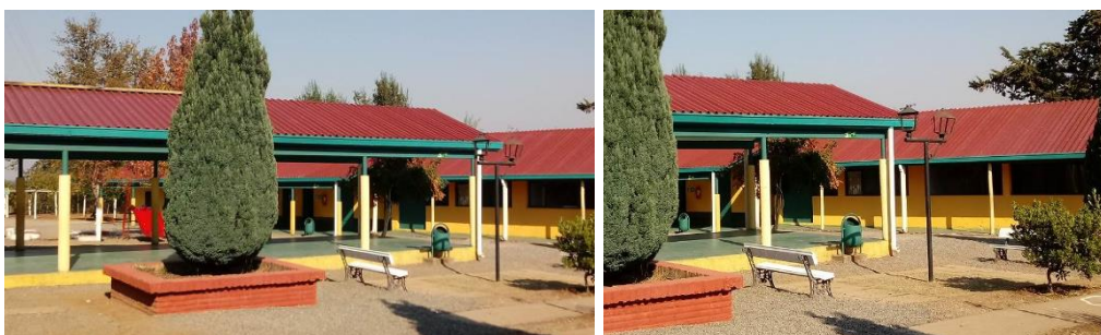
Ejecutado_ Cambio de cubierta _ Escuela Punta de Diamante.
