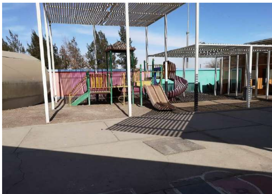
Imagen N°1 Vista general pilares en patios que necesitan cubre pilar.
