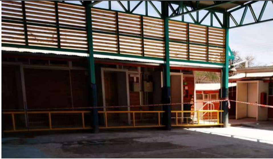
Imagen N°4 Vista detalle sombreadero instalado.
