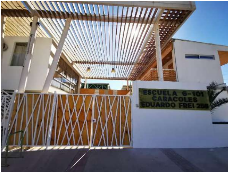
Imagen N°4 fachada principal, instalacion letrero escuela, pintura y recambio portón.
