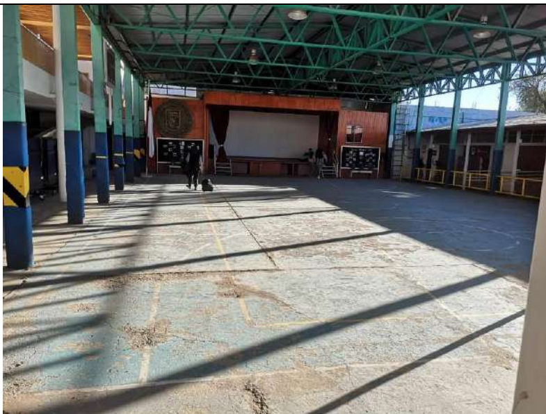
Imagen N°2 Vista interior cancha antes del mejoramiento.
