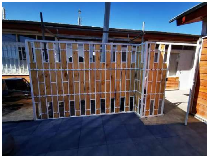
Imagen N°4 Vista detalle cierre perimetral realizado.
