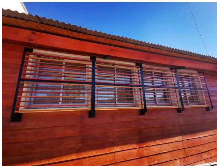
Imagen N°5 protecciones ventanas exteriores.
