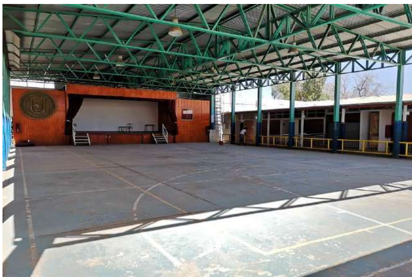
Imagen N°1 Vista general piso patio central antes del proyecto.
