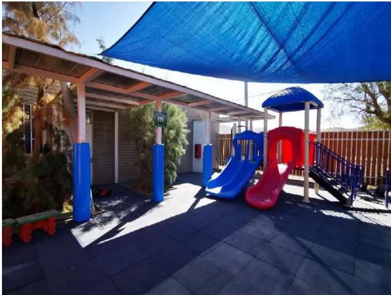
Imagen N°3 Vista general patio, lona, equipamiento, piso y cubrepilares instalados.
