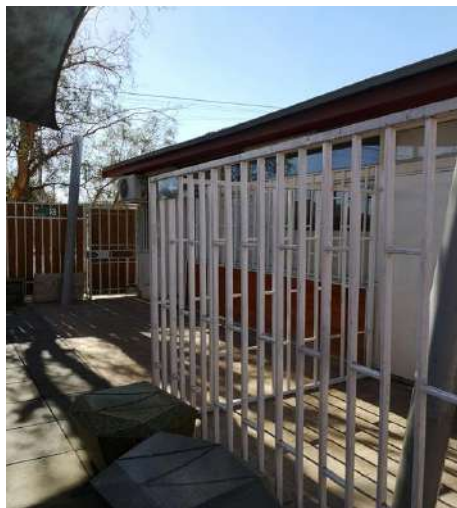
Imagen N°2 Vista cierre perimetral antes del mejoramiento.
