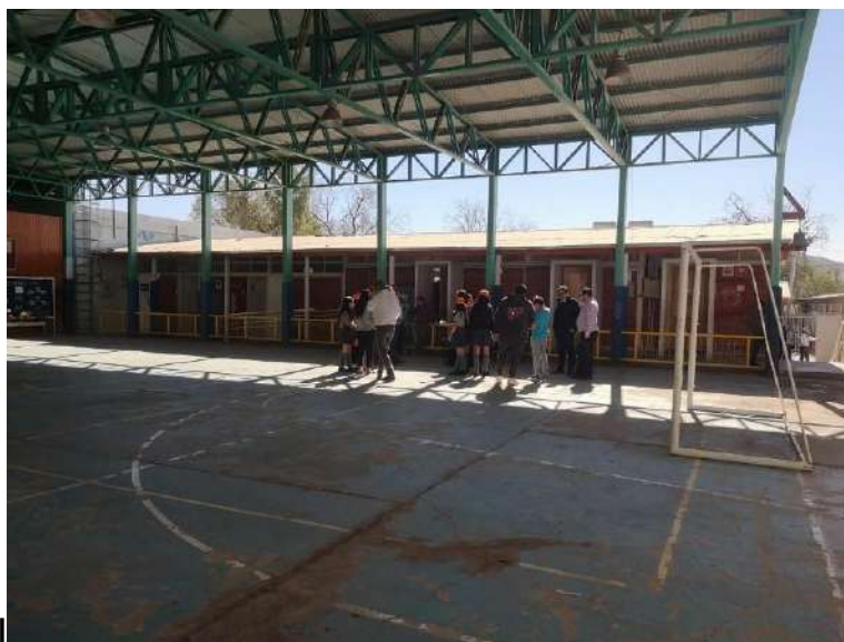
Imagen N°1 Vista general multicancha durante jornada normal, antes del mejoramiento.
