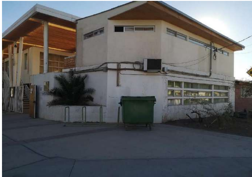
Imagen N°3 Vista lateral antes del mejoramiento.
