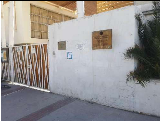
Imagen N°2 Vista fachada principal, antes del mejoramiento.
