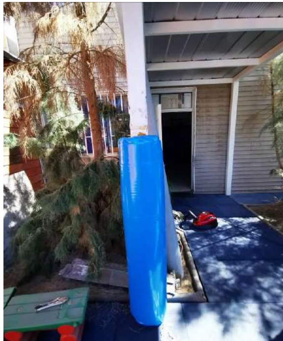
Imagen N°2 tipos de instalaciones cubre pilar.
