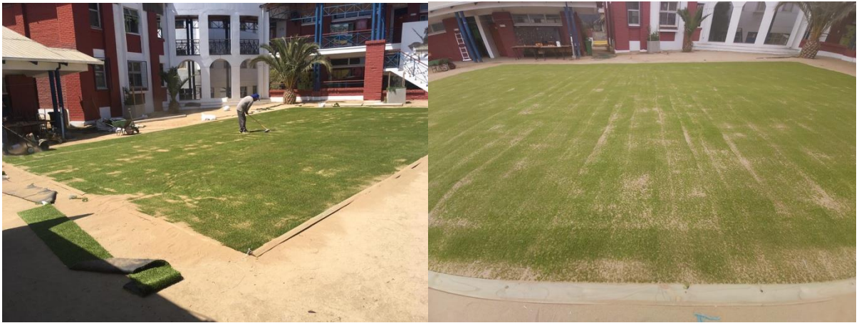
Fig N° 9: Instalación Pasto Sintético Patio Liceo Zapallar.
