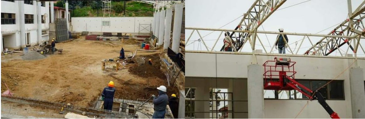
Fig N° 11: Habilitación Gimnasio Escuela Balneario Cachagua
