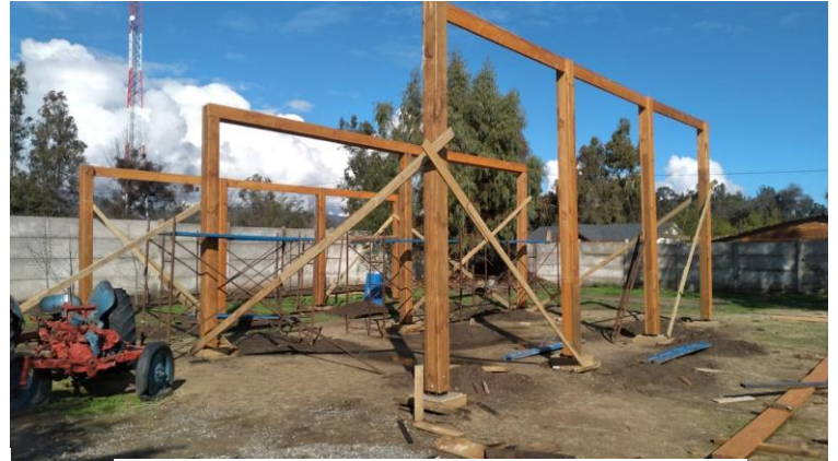
Imagen N°12: Aula Rural en Construcción
