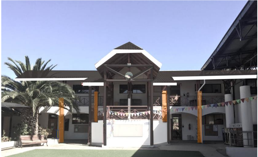
Imagen N°9: Reposición Cubierta y pintura Escuela Balneario Cachagua Bicentenario de Zapallar
